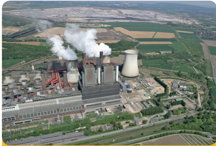
Fig. 1: Façade de la centrale électrique de Weissweiler, vue depuis l'autoroute A4 Aix-la-Chapelle-Cologne. Dans cette centrale, le lignite est transformé en électricité - les «nuages» ne sont pas de la fumée, mais de la vapeur d'eau. En arrière-plan, on voit l'immense trou de la mine à ciel ouvert.
